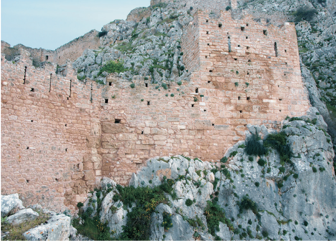
Εικόνα 77: ενδιάμεση γραμμή οχύρωσης II και ο πύργος II1 μετά τις εργασίες
