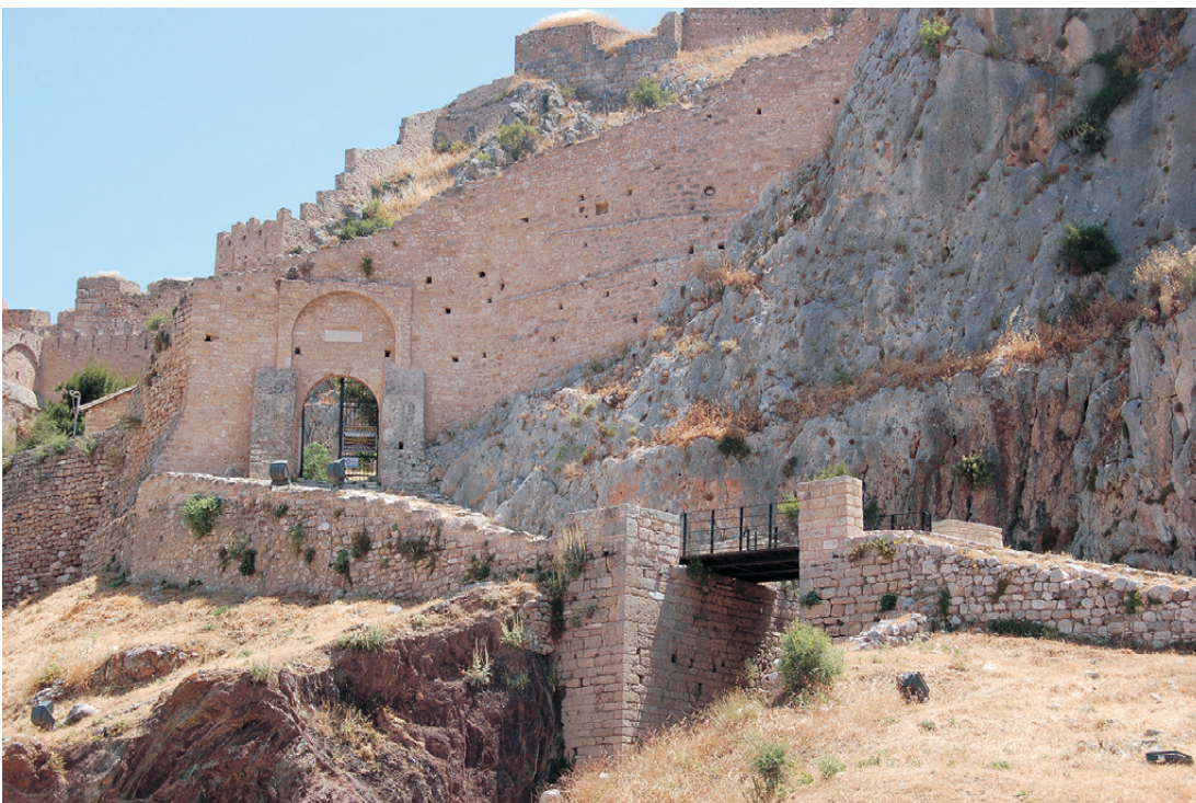
Εικόνα 79: γέφυρα τάφρου Μ και η πύλη G1 της εξωτερικής γραμμής οχύρωσης Ι
