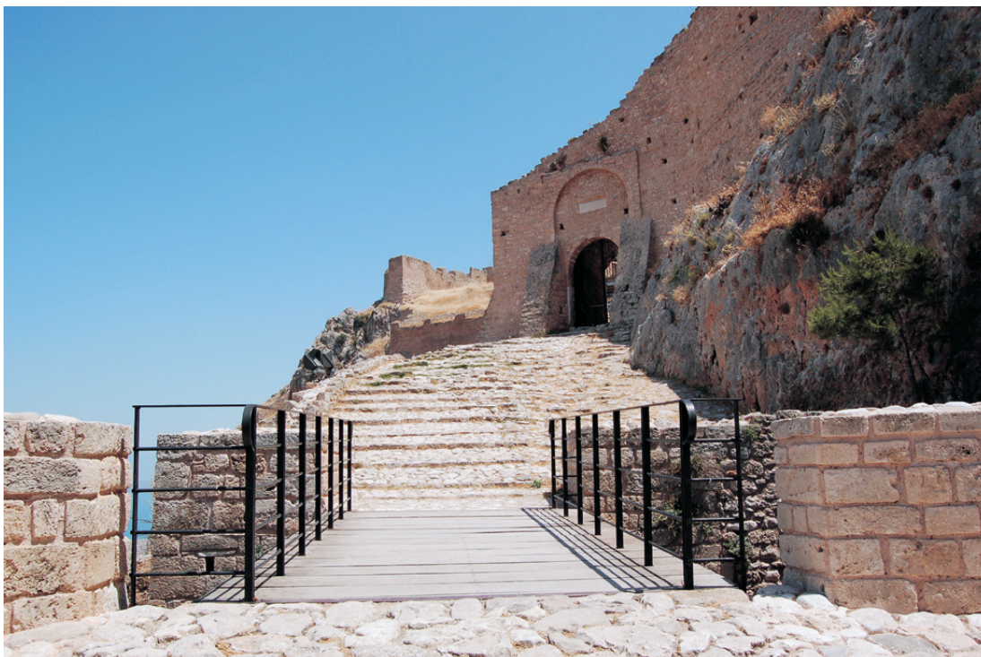
Εικόνα 82: αποκατάσταση γέφυρας τάφρου Μ
